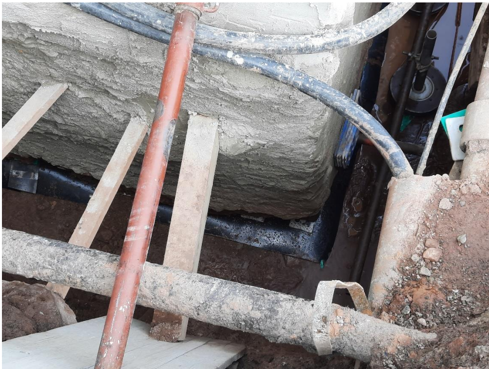
Muzeum – detail vodorovné izolace, V roh budovy
