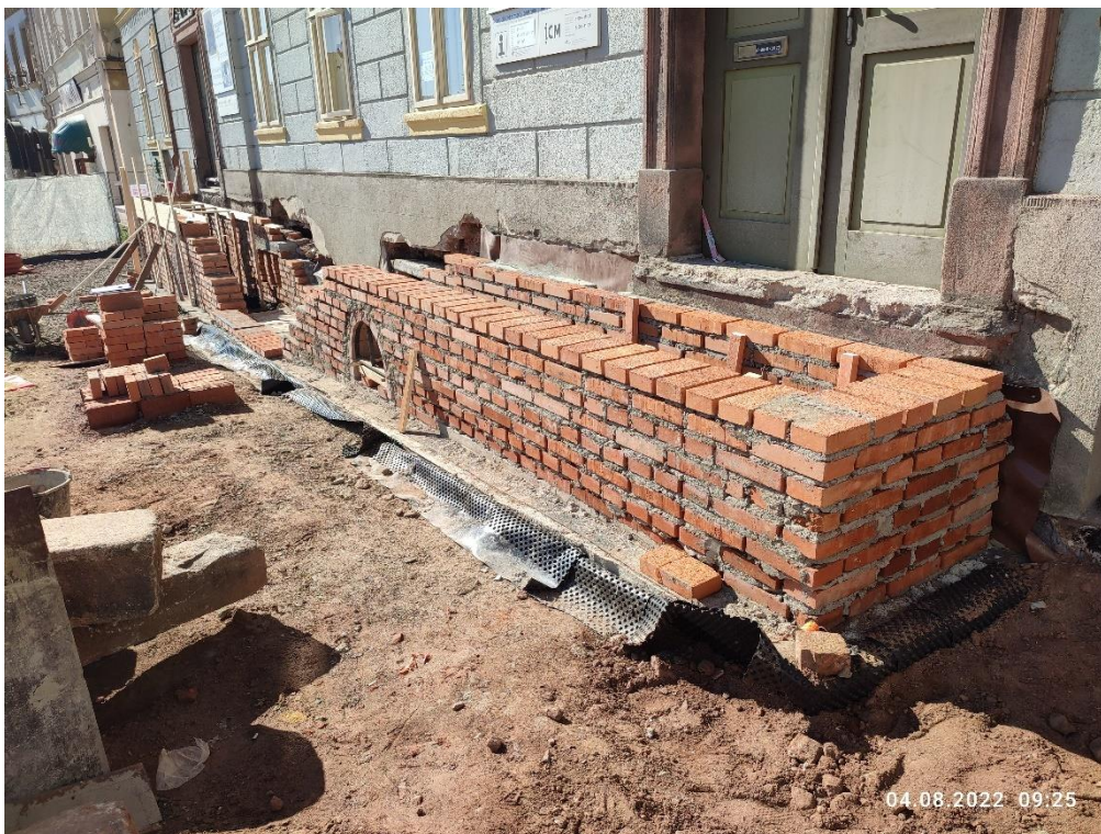
Muzeum – stavba schodů
