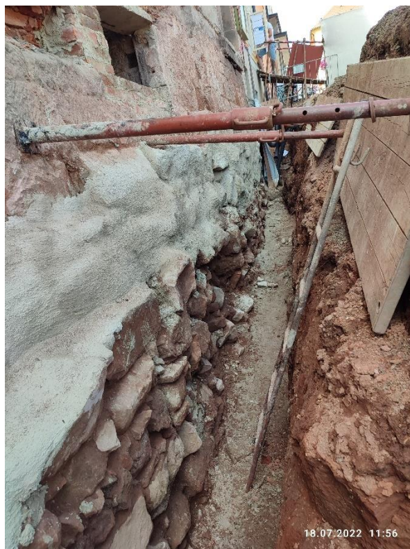
Muzeum – pohled do částečně odkopané spáry kolem zdiva
