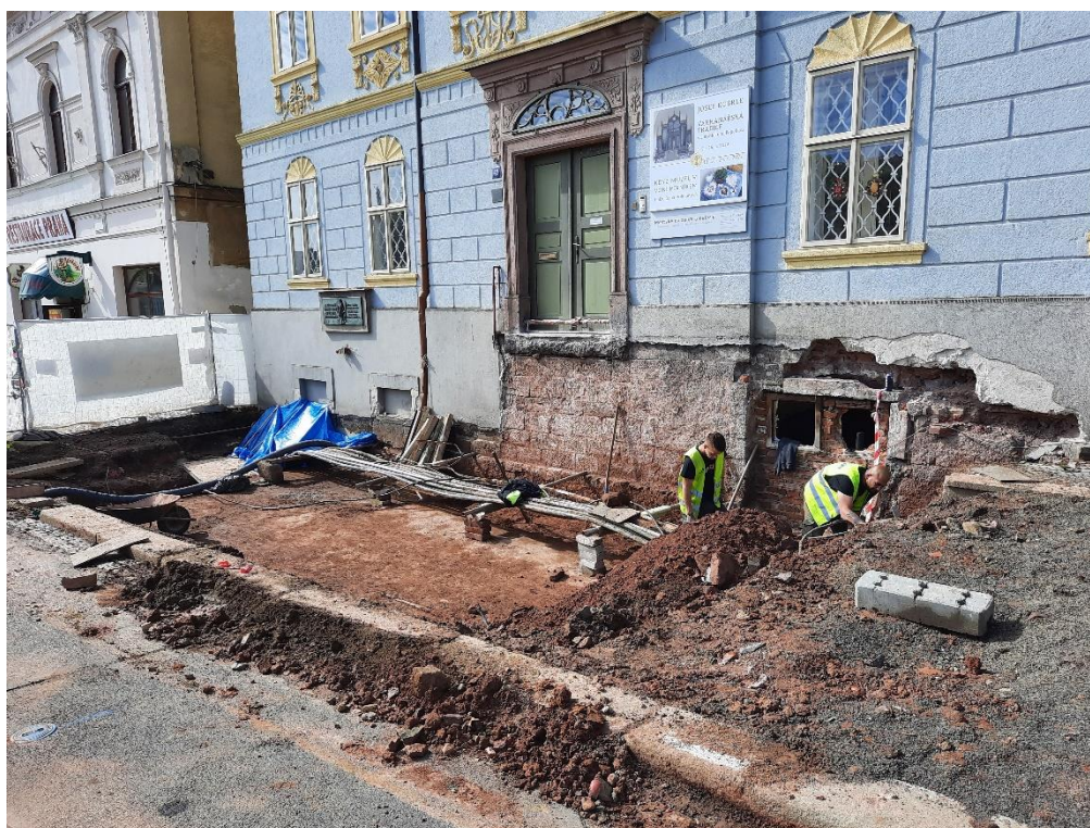
Muzeum – rozebrané schodiště, odhalený sklep pod chodníkem
