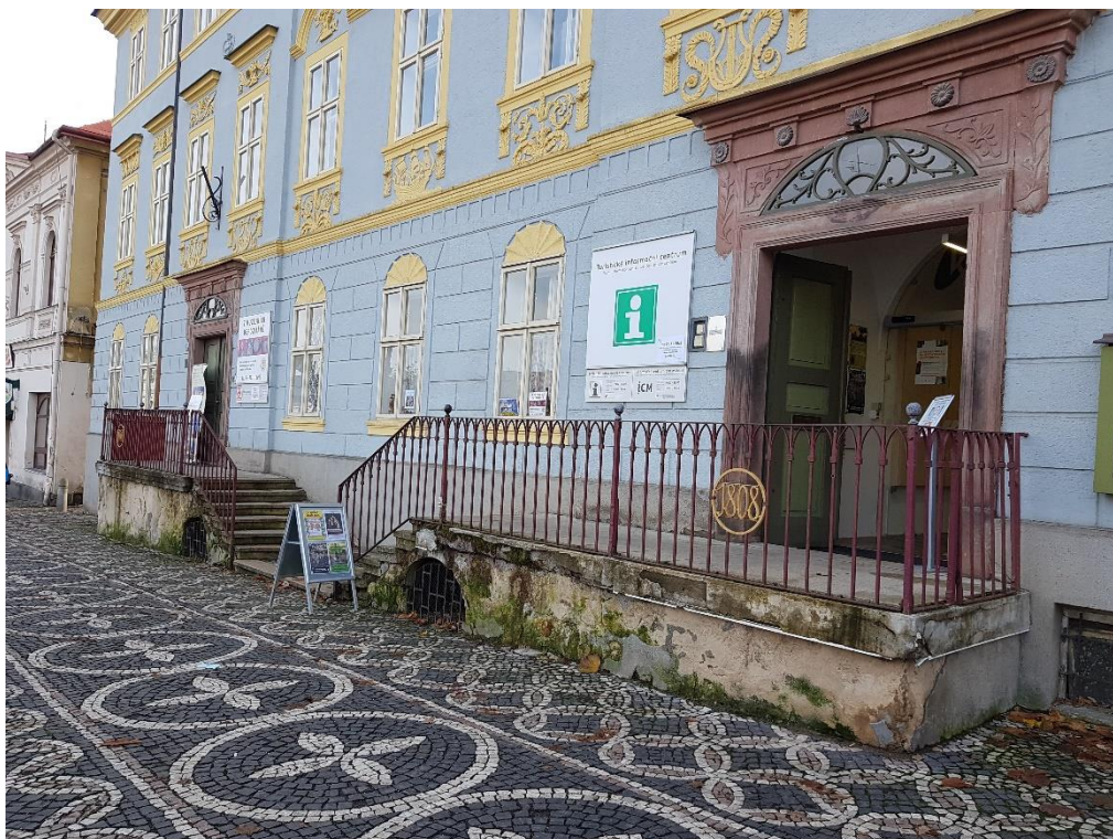
Muzeum, SV průčelí – stav před obnovou
